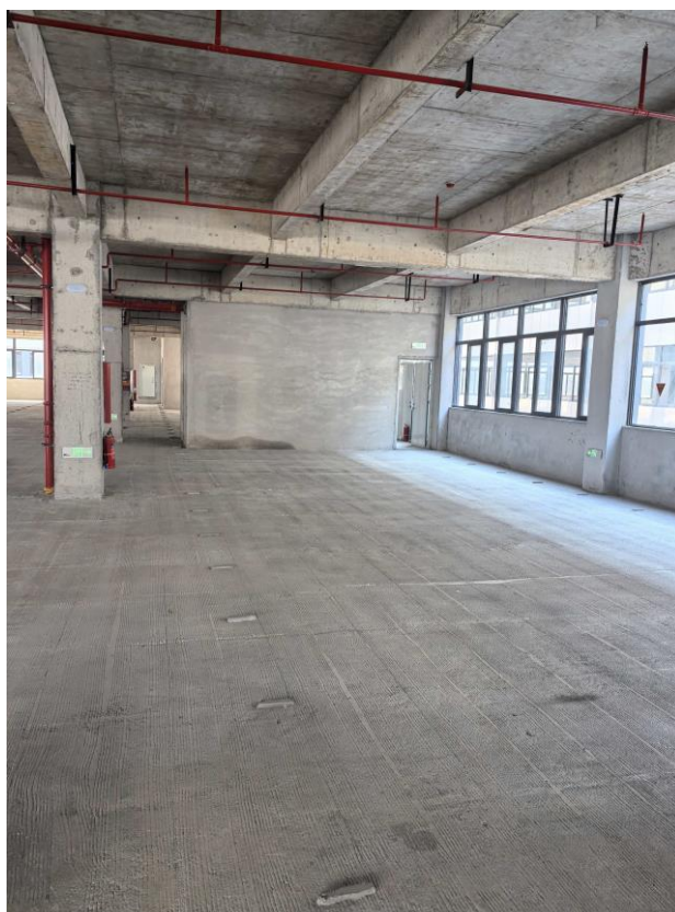
图2-4 本项目空厂房照片
