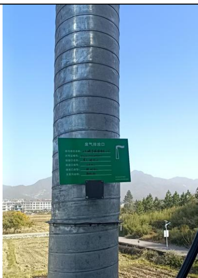
解包配料粉尘废气排气筒
