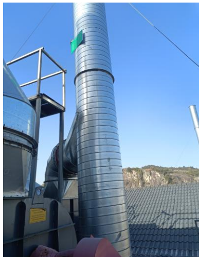
密炼废气、开炼废气、压延废气、硫化及冷却废气废气治理设施及排气筒
