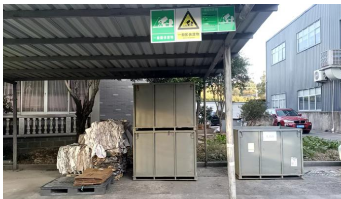
一般固废堆场
