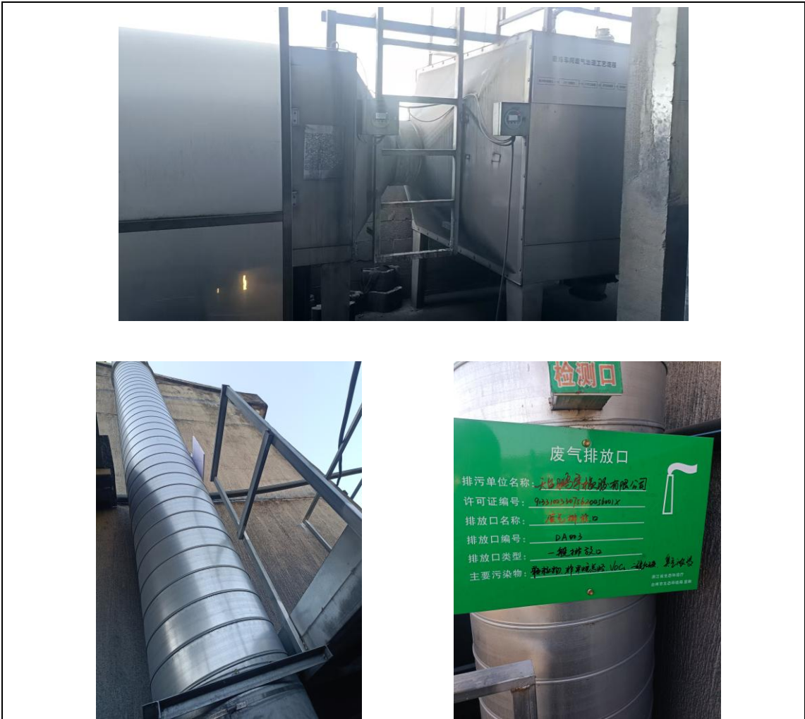
投料粉尘、密炼废气、开炼废气、自然冷却废气废气治理设施及排气筒
