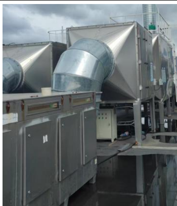
密炼废气、开炼废气、压延废气、硫化及冷却废气废气治理设施及排气筒
