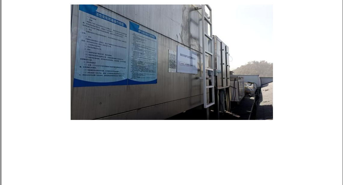
投料粉尘、密炼废气、开炼废气、自然冷却废气废气治理设施及排气筒
