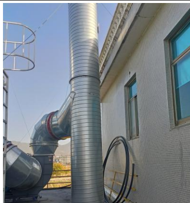
密炼废气、开炼废气、压延废气、硫化及冷却废气废气治理设施及排气筒
