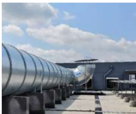
烘胶废气、混炼胶停放废气、胶片冷却废气、塑炼废气、混炼废气、挤出压片废气 排气筒
