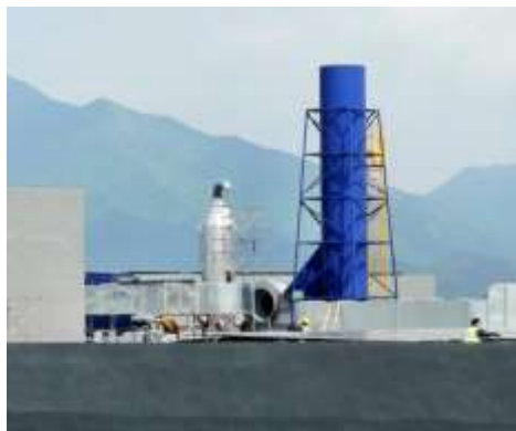
挤出废气、压延废气、硫化废气废气排气筒
