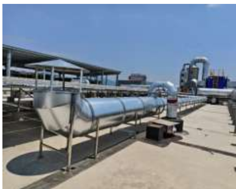
解包配料、投料粉尘废气排气筒
