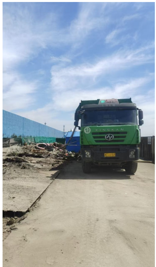
施工期现场5（建筑垃圾清运）
