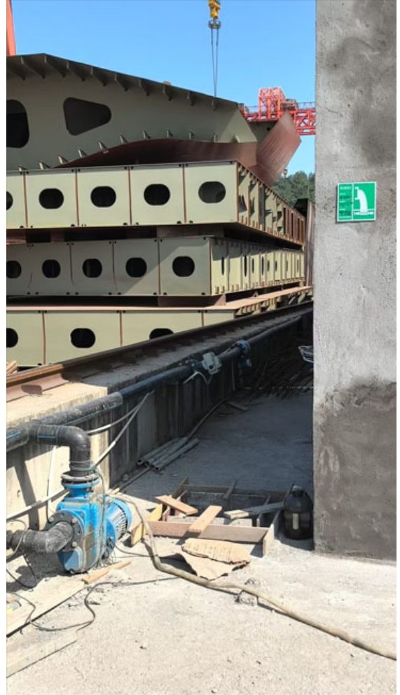
厂区雨水排放口
