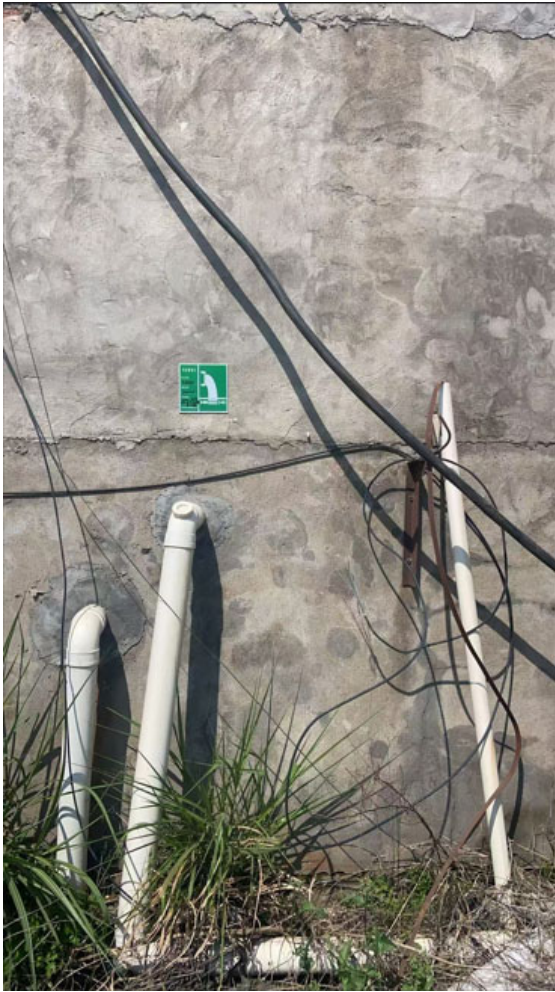
厂区废水总排口
