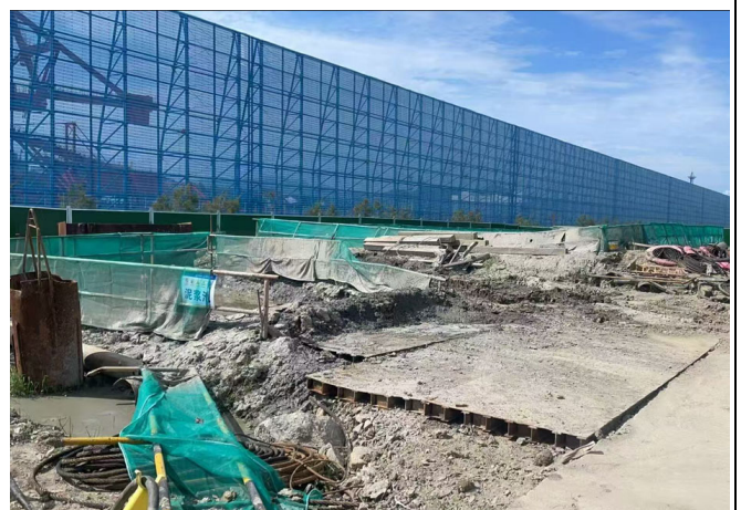
施工期现场1（沉淀池）
