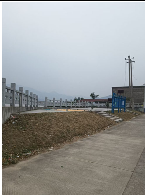
堤塘现状（东段终点）
