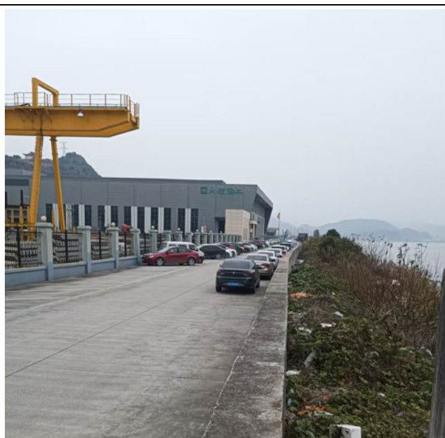
堤塘现状（中-西段）
