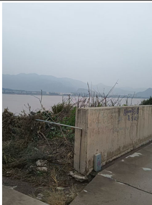
堤塘现状（西段起点）
