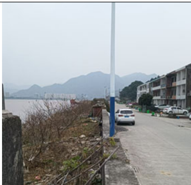
堤塘现状（中-东段）
