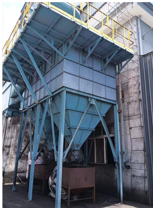
旧砂回收、沸腾床布袋除尘装置
